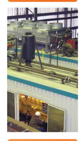
\_ нженеры «Ролт Инжиниринг» провели прочностной анализ силовых конструкций блокмодуля для каждой серии генерирующего оборудования. Конструкторская документация разработана для всех ГПГУ и ДГУ из предлагаемой линейки.
