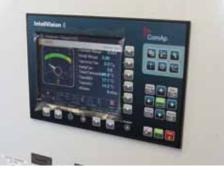
ператор станции с помощью дисплея системы управления, расположенного на лицевой стороне шкафа собственных нужд, может задать режим работы электростанции:
