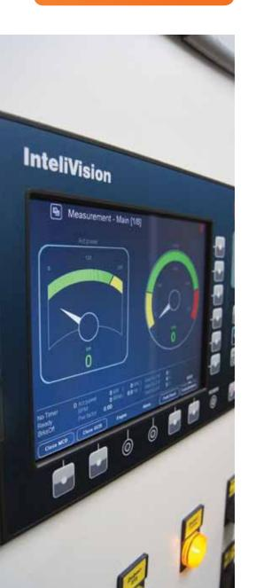
Электростанции ROLT серии PS автоматизированы в объеме 3-й степени автоматизации в соответствии с ГОСТ 14288-80 «Дизели и газовые двигатели автоматизированные. Классификация по объему автоматизации».
